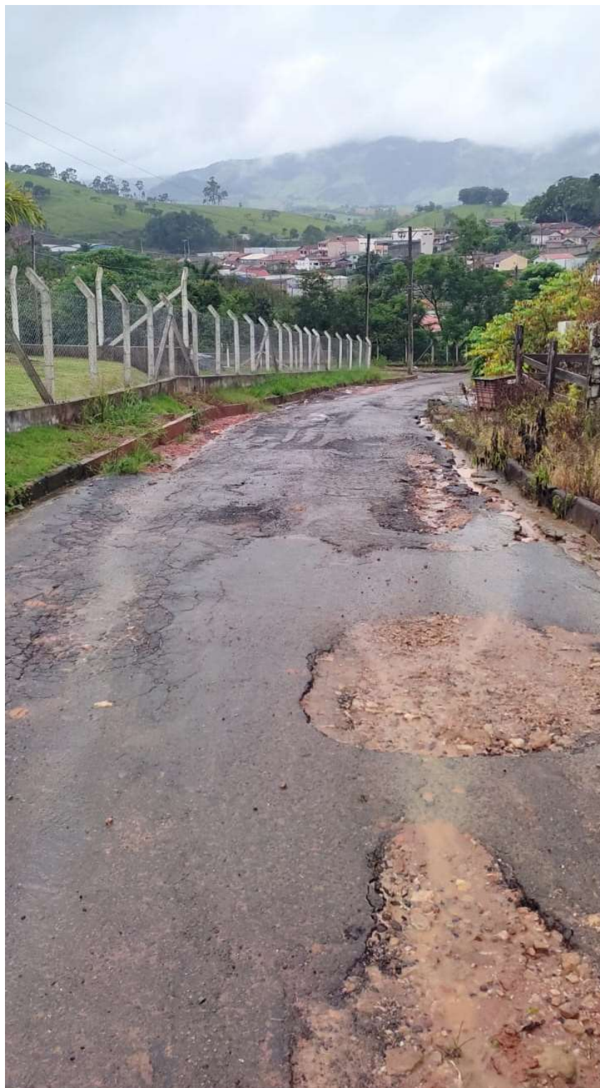
Imagem 02 - Trecho a pavimentar
