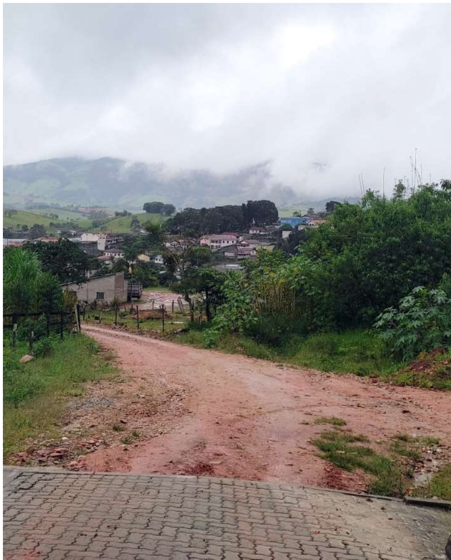
Imagem 01 - Trecho a pavimentar
