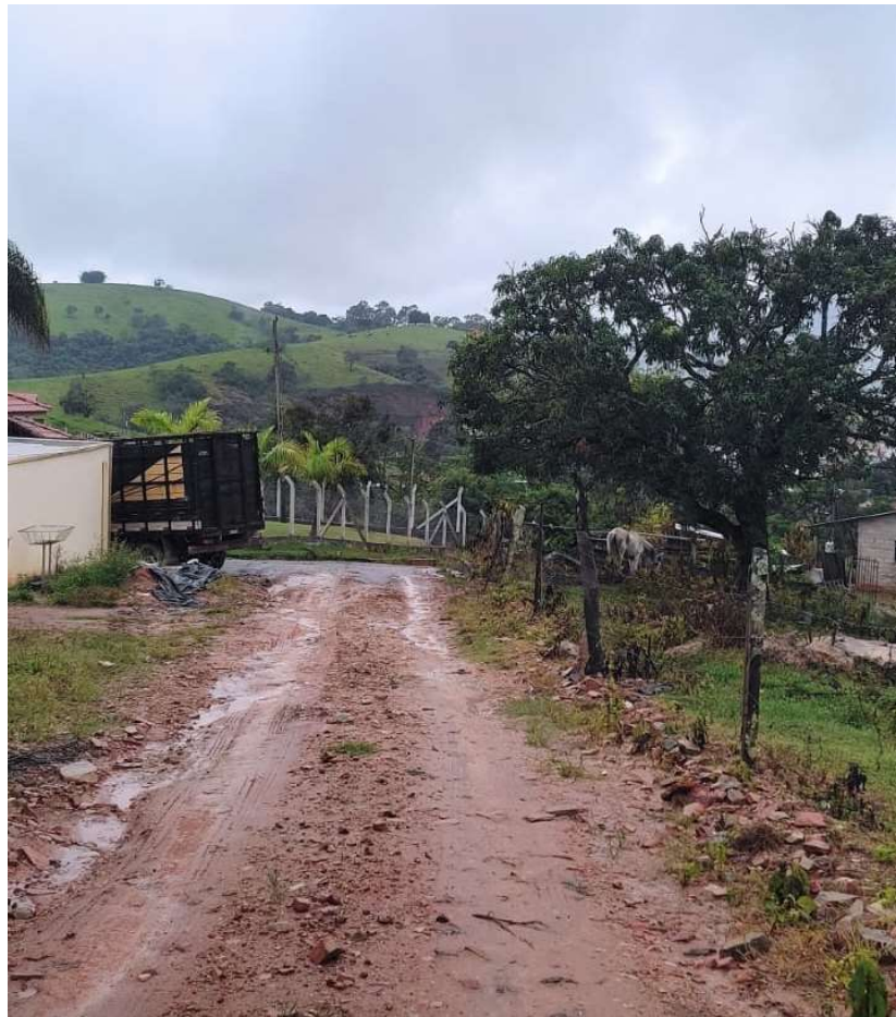
Imagem 03 - Trecho a pavimentar
