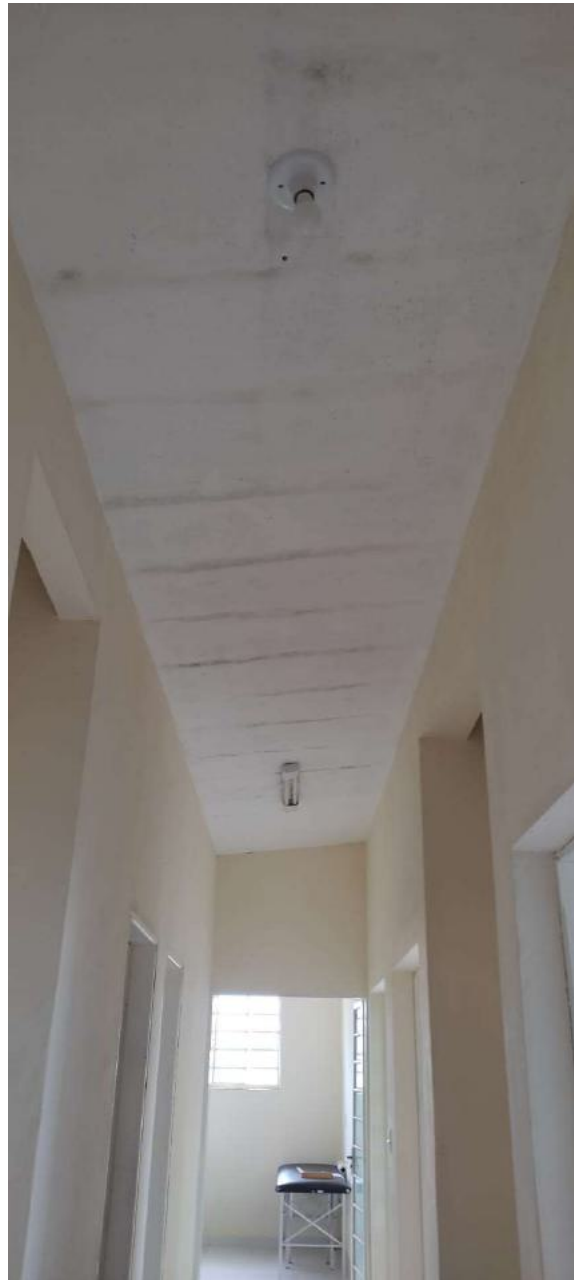
Imagem 05: Corredor interno, toda parte interna receberá pintura e reparos onde for necessário.
