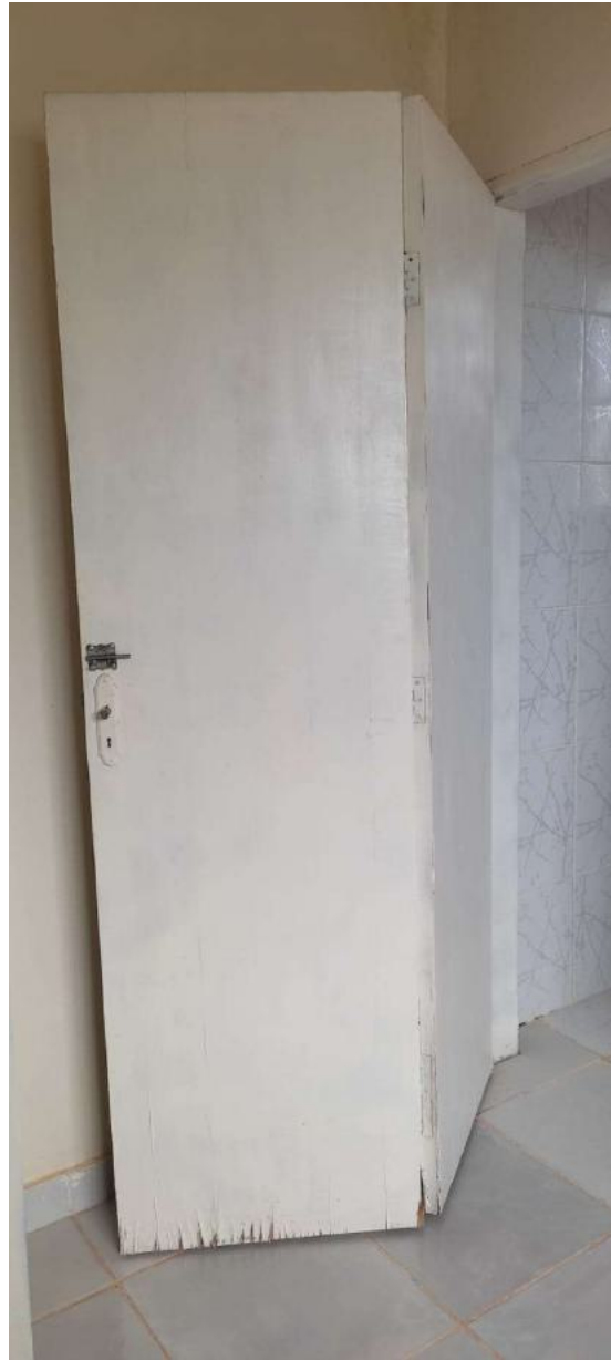
Imagem 06: Porta interna que será substituída.
