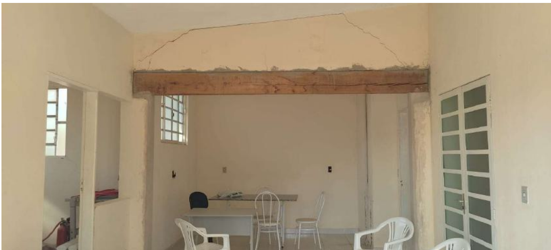
Imagem 04: Vão que receberá alvenaria e viga de sustentação.
