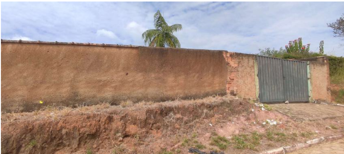
Imagem 02: Fachada com muro e portão que serão substituídos por grade e portões novos.
