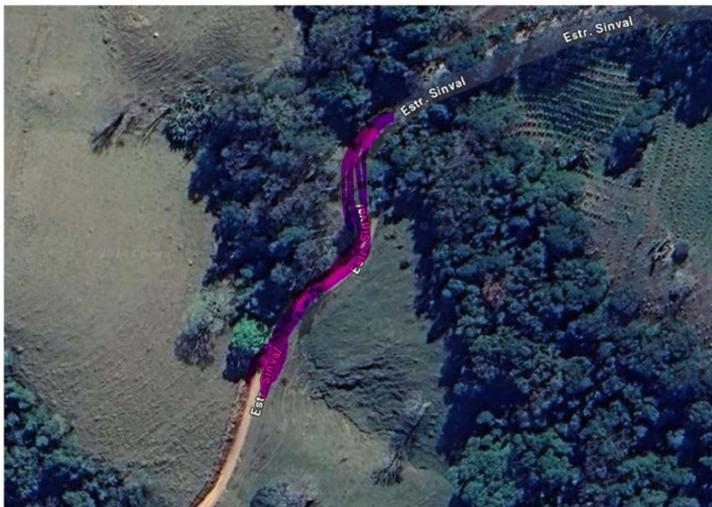
TRECHO I – ESTRADA DA CURVA DA FERRADURA
