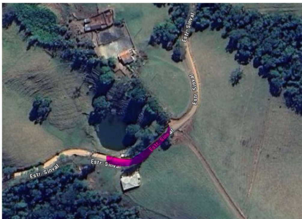
TRECHO I – ESTRADA DA CURVA DA FERRADURA
